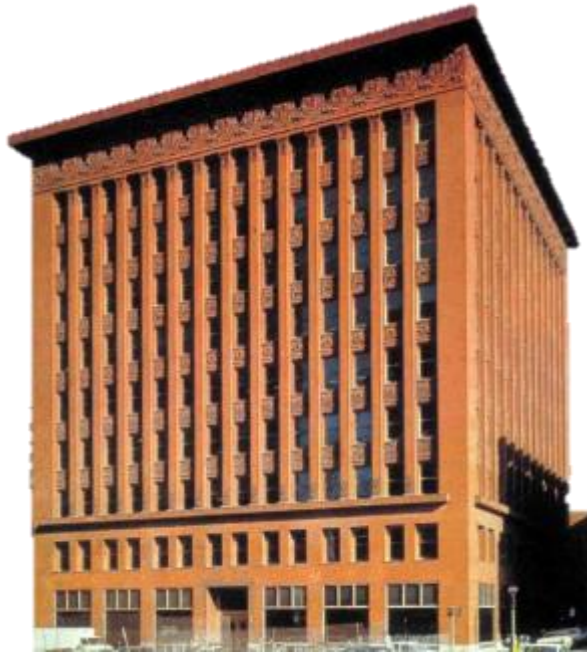
Fig.48 EDIFICIO WAINWRIGHT (1890-1891) LOUIS HENRY SULLIVAN SAINT LOUIS, MISURI, ESTADOS UNIDOS
