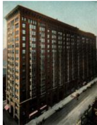
Fig.49 EDIF. MONADNOCK, (1891-1893) BURNHAM & ROOT CHICAGO, ILLINOIS ESTADOS UNIDOS
